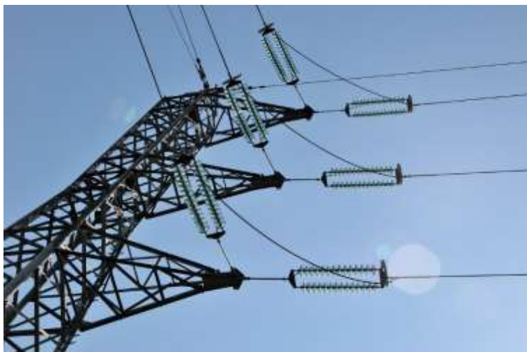
Photographie n°37. Pylône électrique
