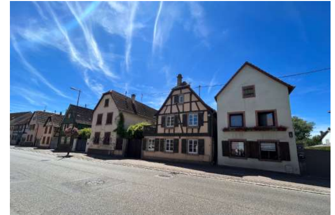
Alignement avenue de Strasbourg
