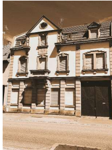
Maison de maître au 41 avenue de Strasbourg
