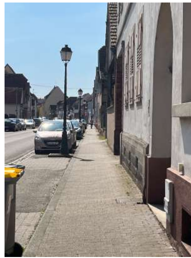
Alignement rue du Général Duport
