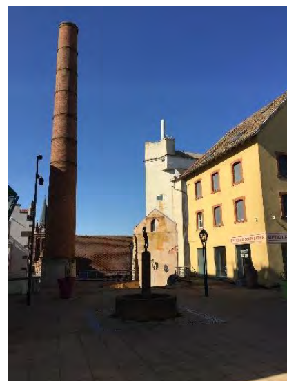
Bâti industriel reconverti, Pfaffenhoffen
