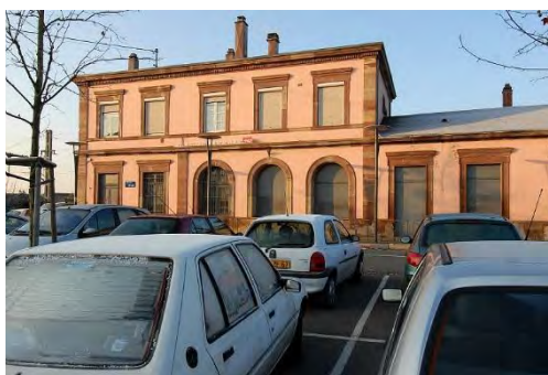
Le bâtiment voyageur vacant, gare de Brumath
