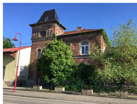
La gare désaffectée, Pfaffenhoffen
