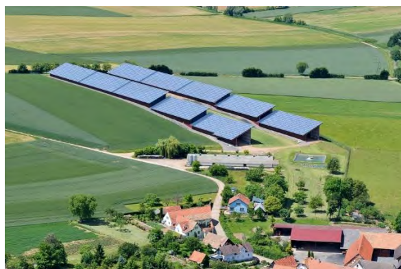
Photographie n°24. Centrale solaire agricole à Uhlwiller et Engwiller
