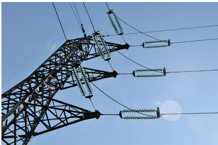
Photographie n°37. Pylône électrique
