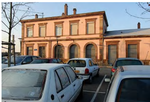
Le bâtiment voyageur vacant, gare de Brumath
