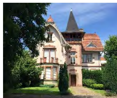
Maison de maître, Haguenau
