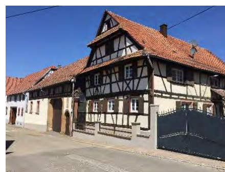
Corps de ferme, Rottelsheim
