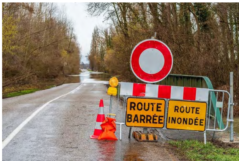
Photographie n°29. Route barrée lors de crue
