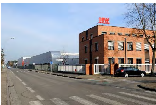
Photographie n°33. Installation présentant un risque technologique
