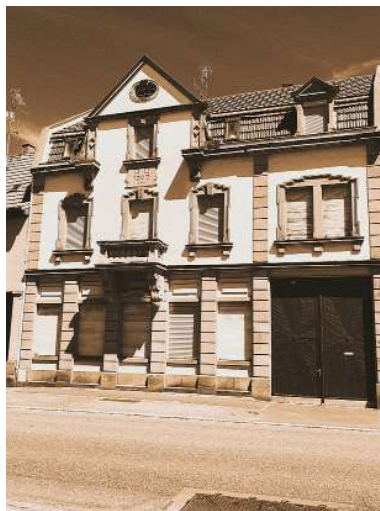
Maison de maître au 41 avenue de Strasbourg
